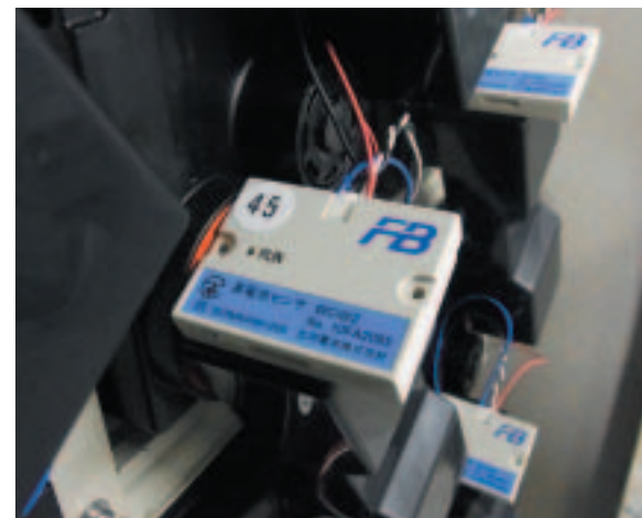
蓄電池センサー (BCW) の設置例 Examples of BCW installations
