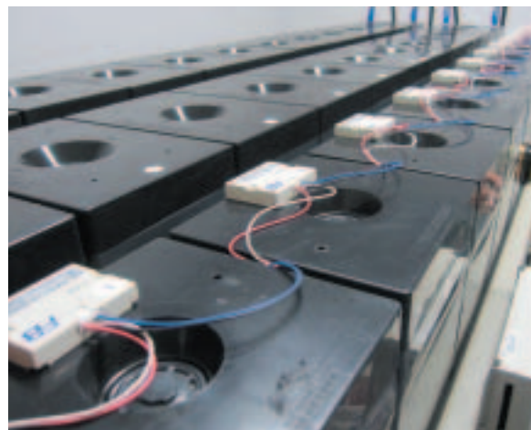
蓄電池センサー (BCW) の設置例 Examples of BCW installations
