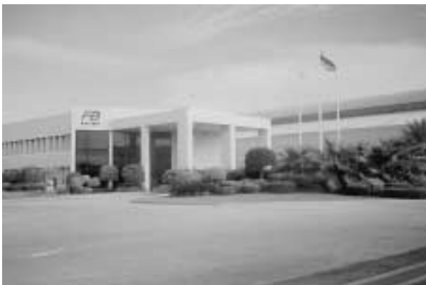
写真1 新工場の外観 Photo 1 Appearance of the new plant
