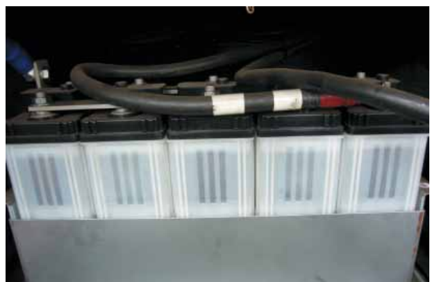
写真4 1年経過後の電解液面推移 (2007年4月) Photo 4 Electrolyte level after one year
