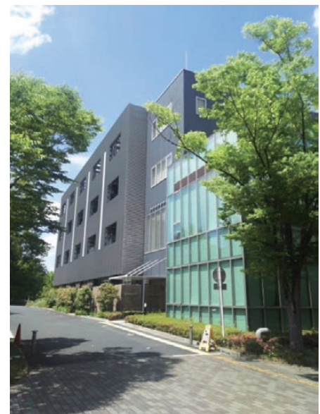
首都大学東京プロジェクト棟
